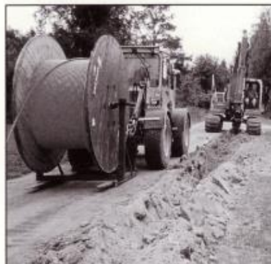
Schakten går längs Brunnsjövägen.
